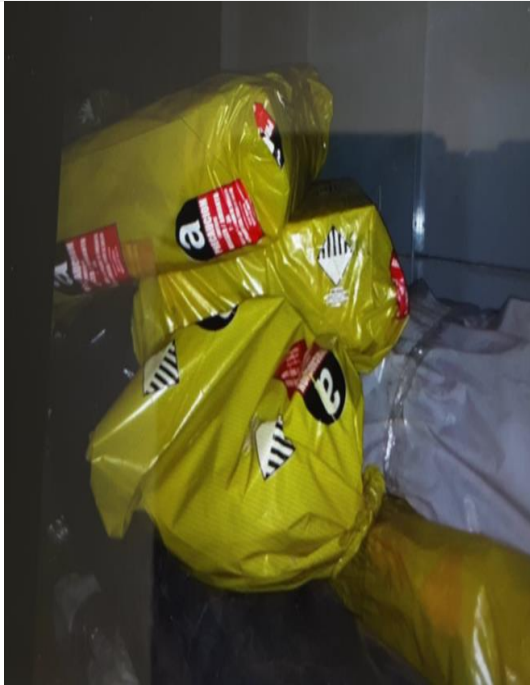
Foto 3 - Bolsas de polietileno de 200 micrones de espesor con sus características de embolsado y rotulado, no mayor al peso de su manipulación cuyo límite es de 20 kilos (residuos del asbesto) de acuerdo a la Resolución MT y SS N° 577/91..
