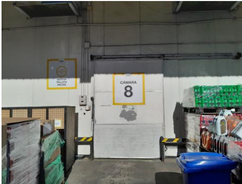
Cámara de frío para producto yogurt
